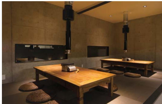
卓上コンロと上引き排煙フードを採用することでテーブル選びが自由になった。宴会時にはつなげて長テーブル仕様にもできる
